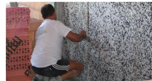
Evitare la formazione di eventuali ponti acustici edificando la muratura o posando i placcaggi in cartongesso su un supporto orizzontale resiliente tipo **CIRFONIC PAV 2000**, costituito da un agglomerato poliuretano ad alta densità in grado di creare discontinuità strutturale. (foto 1)
