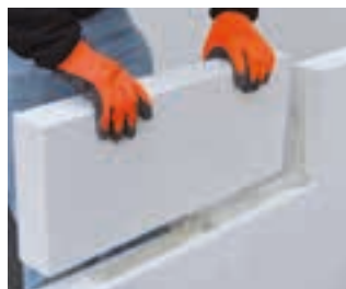
Posa di blocchi GASBETON®
