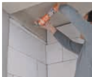
Sigillatura giunti sottili verticali/orizzont.
