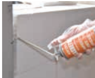
Sigillatura giunti sottili verticali/orizzont.
