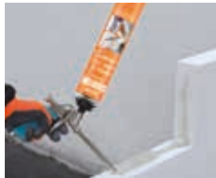
Posa di blocchi GASBETON®
