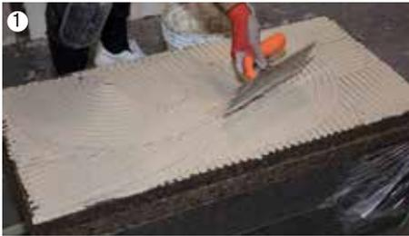
1. Stendere il collante **TECNOFIX P10** a tutta superficie sul pannello con una spatola dentata da 8-10mm (1). Applicare il pannello premendo contro il supporto. Applicare n. 2 tasselli **TECNOTAS** per pannello (2).
