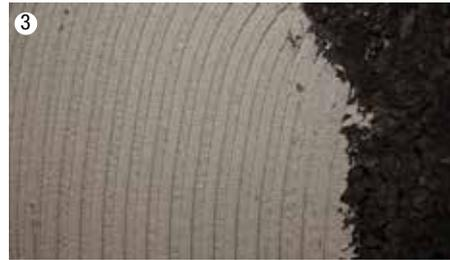
3. Realizzare la rasatura con **TECNOFIX P10** (3). Appoggiare la rete in fibra di vetro, schiacciandola leggermente. Applicare la seconda mano di **TECNOFIX P10**, rendendo la superficie liscia (4).
