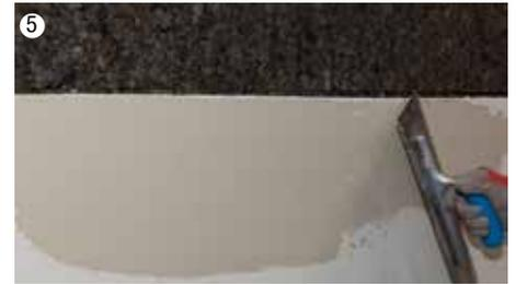
5. Applicare la prima mano di **CALCINA LISCIA** o **CIVILE** (5). Una volta asciutta, applicare la seconda mano con lo spesso prodotto. Stendere il fondo **TECNOBASE ZERO** e poi la pittura **TECNOPAINT ZERO** in due mani (6).
