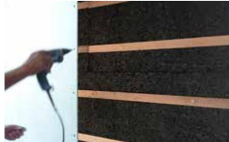
Avvitare il pannello **fermacell greenline** ai listelli di legno e applicare l'apposito adesivo **greenline** sul bordo del pannello appena fissato e posizionare il successivo. Procedere fino al completamento della parete.
