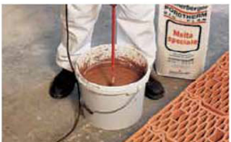
Preparazione della malta speciale
