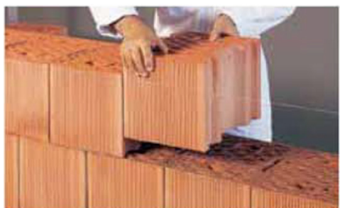
Posa dei blocchi
