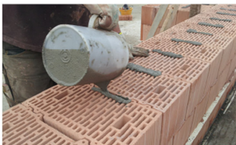
Riempimento delle tasche di malta
