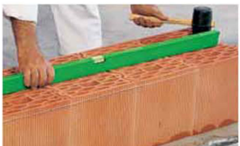
Livellamento del primo corso
