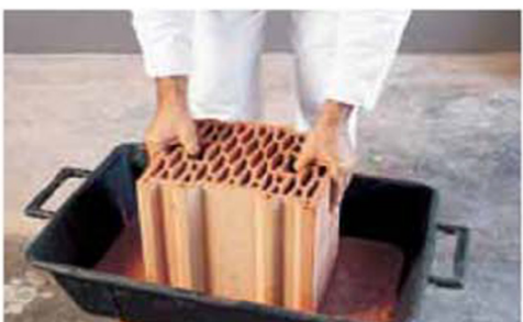
L'applicazione della malta per immersione
