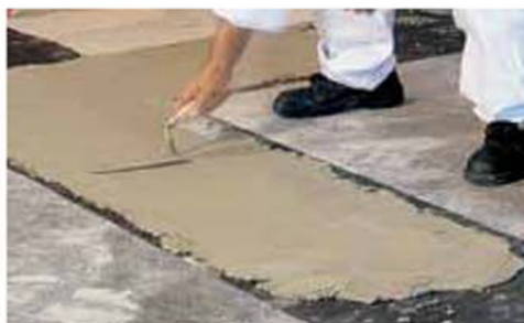
Predisposizione della guaina per l'umidità di risalita
