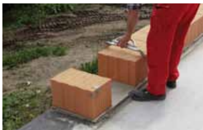
Posa dei blocchi del primo corso
