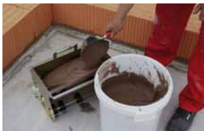
Riempimento del rullo stendi malta con la malta speciale
