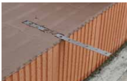
Predisposizione degli ancoraggi per il collegamento con i tramezzi interni
