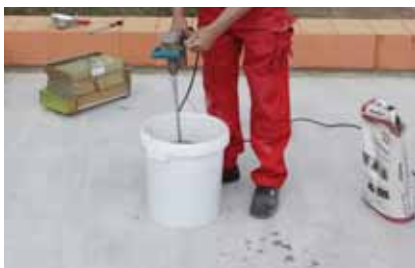
Preparazione della malta speciale
