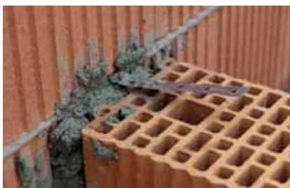
Realizzazione della tramezzatura con l'inserimento degli ancoraggi
