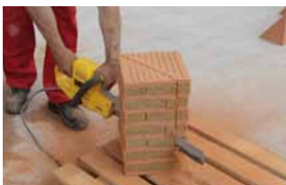
Taglio con idonea sega ad acqua, a banco o motosega con lama per laterizio
