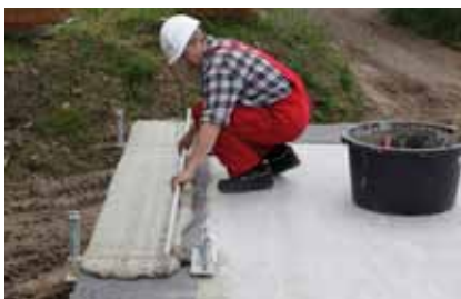
Realizzazione del massetto di partenza a livello
