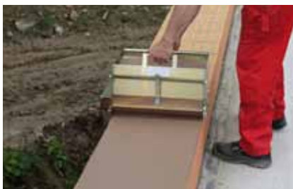
Applicazione della malta con il rullo
