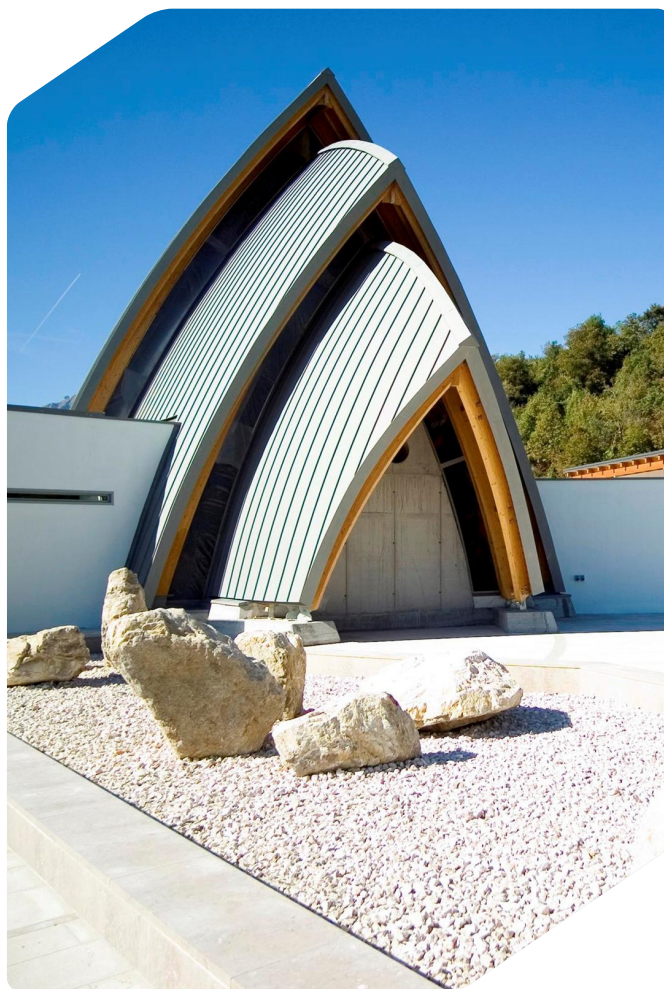
Chiesa Di Mas Peron (BI) (Italia) - Studio Architetto Alberto De Biasio - Installatore dello zinco Chiesa SRL
