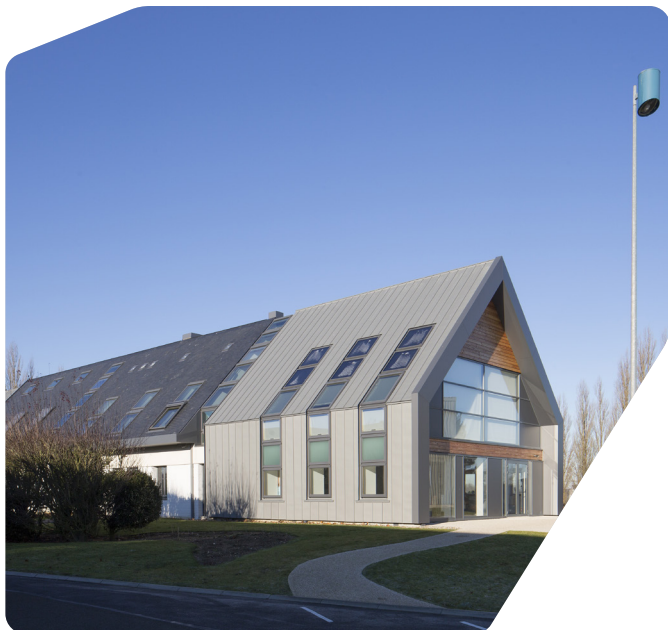
Edificio Amministrativo VKR France, Feuquières en Vimeu (Francia) - Studio BTC
