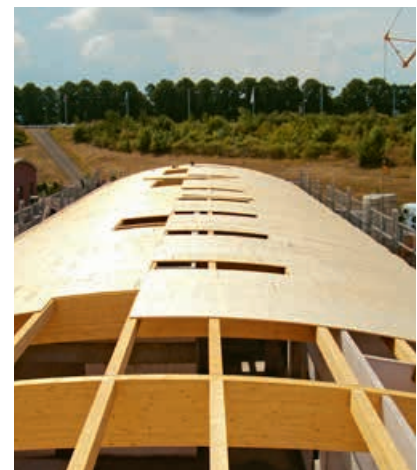
Esempio: pannelli per coperture a campata libera altamente prestante in edifici commerciali e capannoni.
