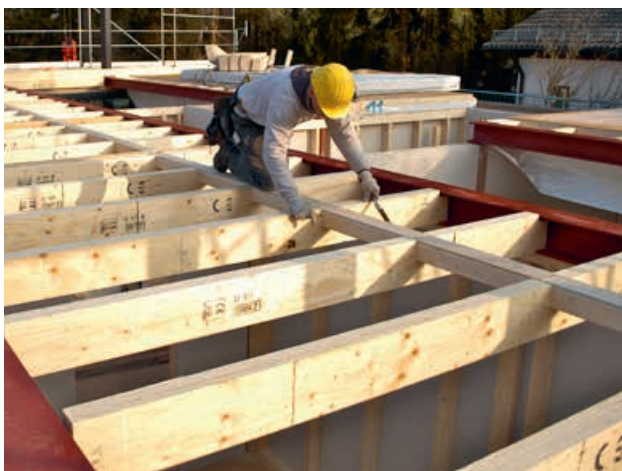
STEICO LVL R usato nella costruzione di strutture portanti per solai.
