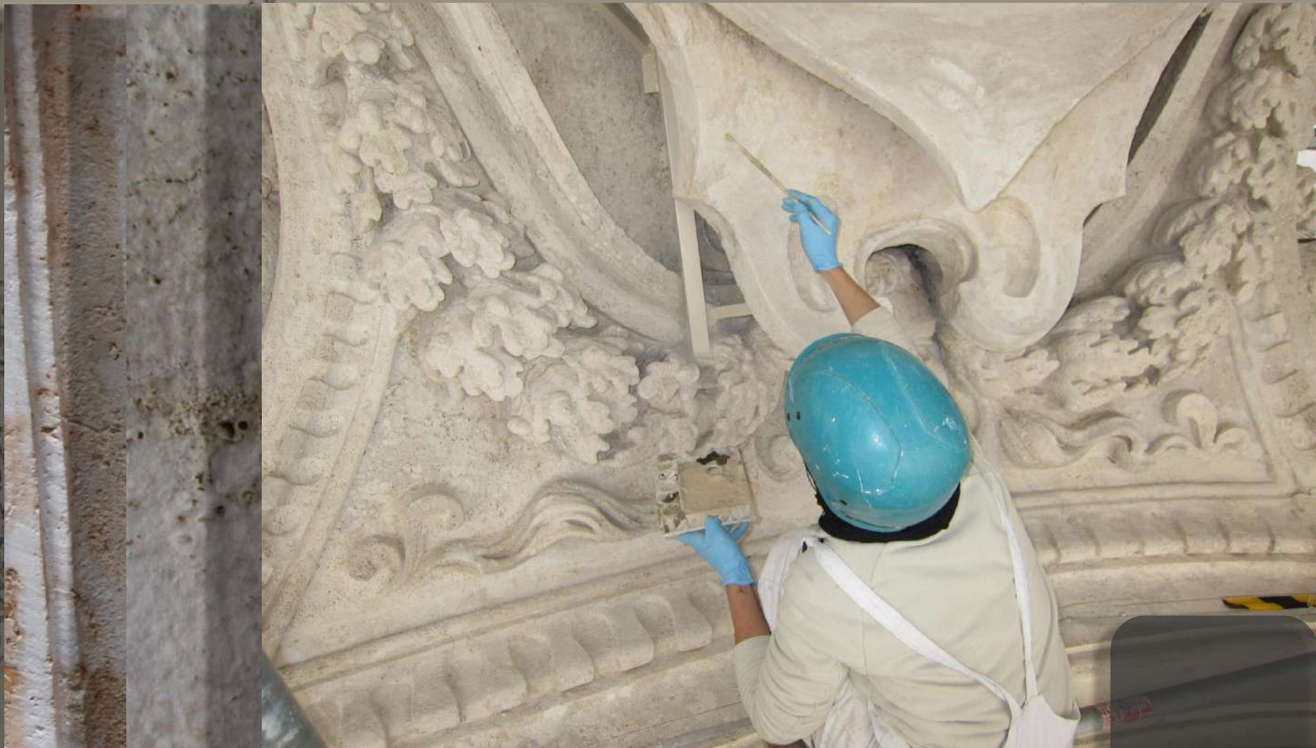
Intervento di restauro con silicato di Potassio
