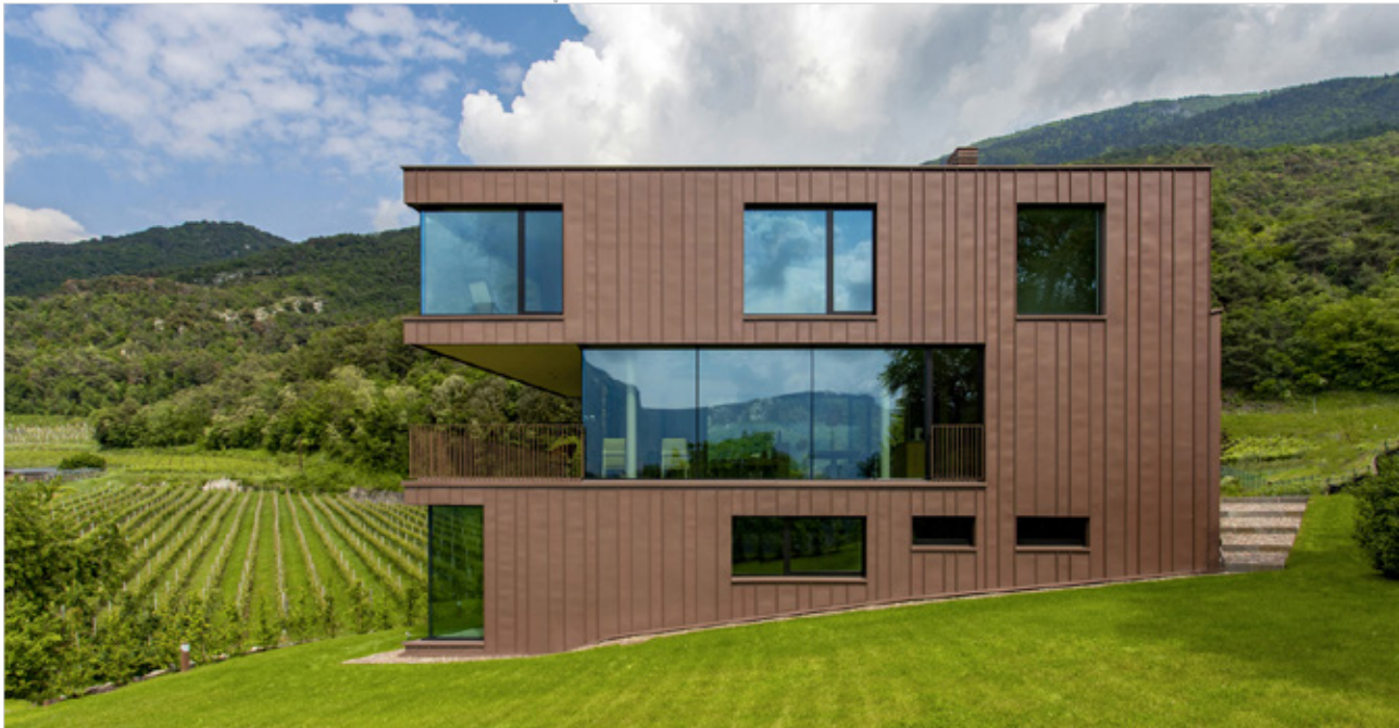
VILLA PRIVATA facciata con rivestimento verticale in aggraffatura angolare VMZINC® PIGMENTO® FAC AA in laminato in lega di zinco-titanio
