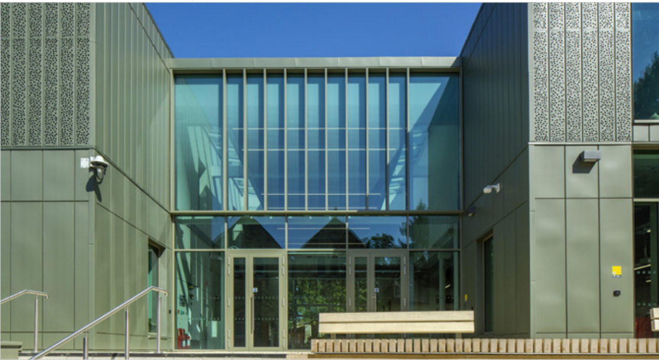
Sistema di facciata a profilo sinusoidale su sottostruttura in legno o metallo
