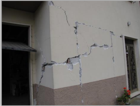
Tamponamento aperture preesistenti
